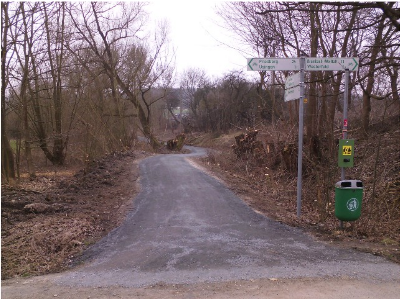
Bild 1: Wegzustand in der Nähe der ehemaligen Seemühle
