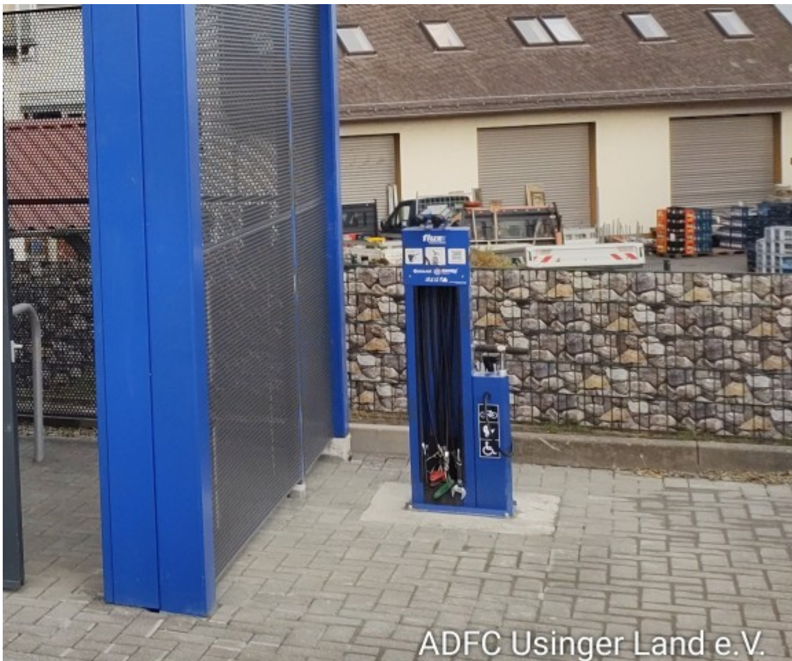
Bild 01: verkehrt aufgestellte Reparaturstele; Verortung in Open Street Map
