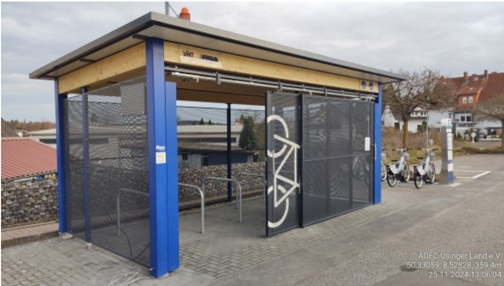
Bild 02: Fahrradparkhäuschen am Bahnhof Usingen vor Fertigstellung; Verortung in Open Street Map
