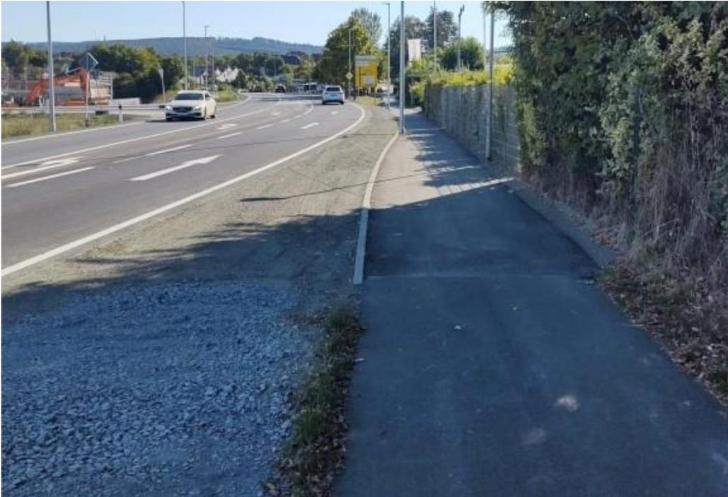
Bild 01: Verengung des Fuß-/Radwegs von 2,0 Meter auf 1,4 Meter bei 1,5 Meter Bankett, Verortung in [Open Street Map](#), © Open Street Map ([osm.org](#))
