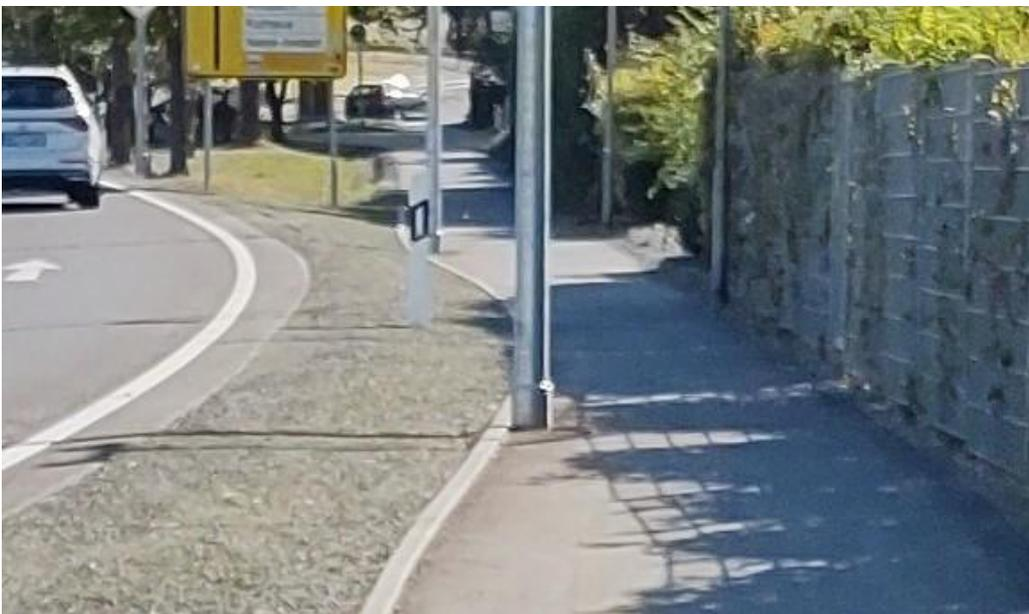
Bild 02: Restbreite Fuß-/Radweg mit 1,4 Metern bei Einbauten (Laternenmast) sowie angrenzendem Zaun, Verortung in [Open Street Map](#), © Open Street Map ([osm.org](#))
